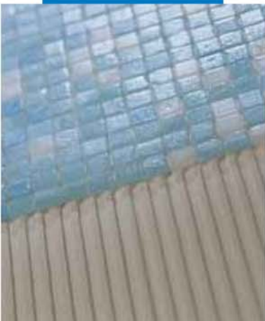
Укладка стеклянной мозаики 1x1 для стену
